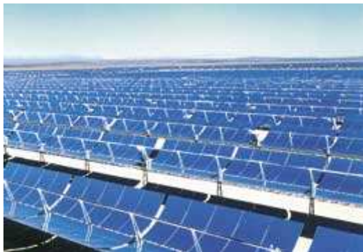
Impianto solare a specchi parabolici realizzato a Kramer Junction, in California (Usa). Un progetto di un impianto di questo tipo è in avanzata fase di realizzazione da parte del Crs4 di Cagliari metalmeccanica e componentistica».
