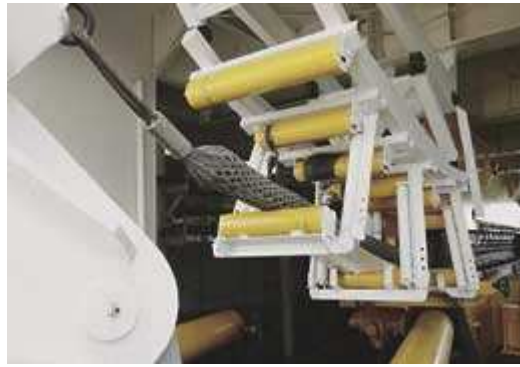
Posa sul fondo sottomarino del primo dei due cavi dell'elettrodotto Sapei da parte della nave "Giulio Verne". Il completamento dell'opera, una delle più importanti programmate da Terna per potenziare il sistema elettrico nazionale, è previsto entro il 2010
